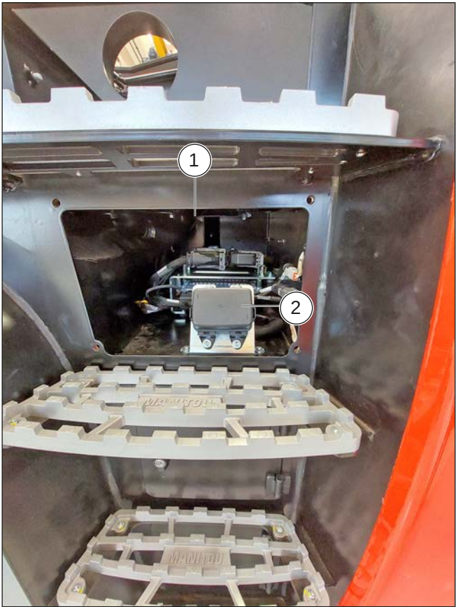
Figur 222: Sikringsdåse og relæer motor
