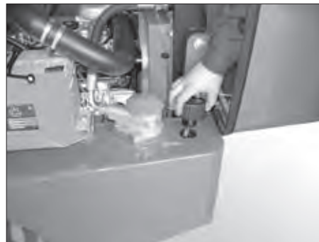
Fig. 63 Reducering af resttrykket
