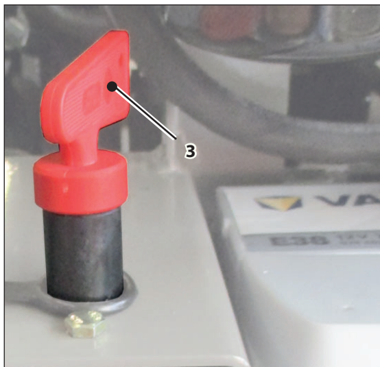
Fig. 20 Tilslutning af batterihovedafbryder
